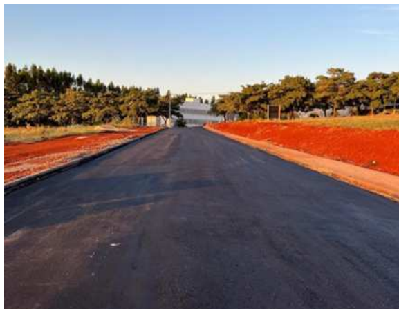
FIGURA 80: Pavimentação da via do novo Almoxarifado Central
