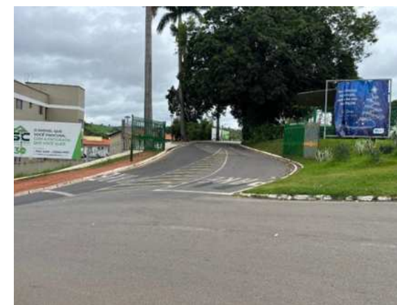
FIGURA 75: Ampliação da portaria principal
