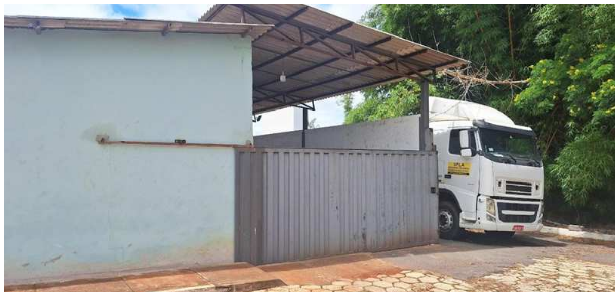
FIGURA 88: Portão da garagem do Mamute
