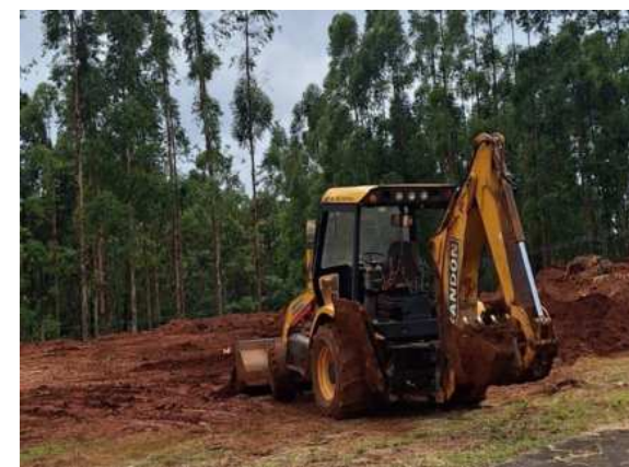
FIGURA 93: Retroescavadeira da UFLA em funcionamento
