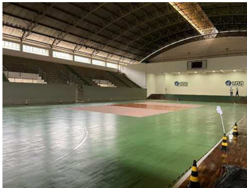
FIGURA 76: Reforma da quadra do ginásio
